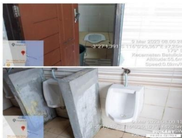
Gambar 4. 24 Kondisi di dalam toilet
