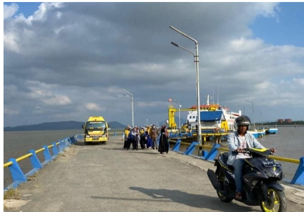
Gambar 4. 58 Penumpang yang Berjalan Melalui Trestle
