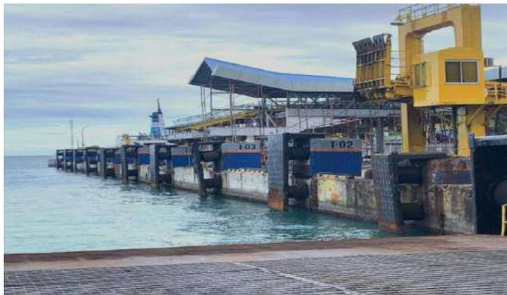
Gambar 4. 26 *Fender* Pelabuhan Penyeberangan Bakauheni
