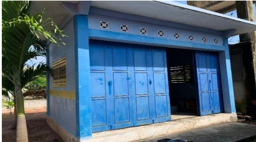
.Gambar 4.12 Ruang Genset
