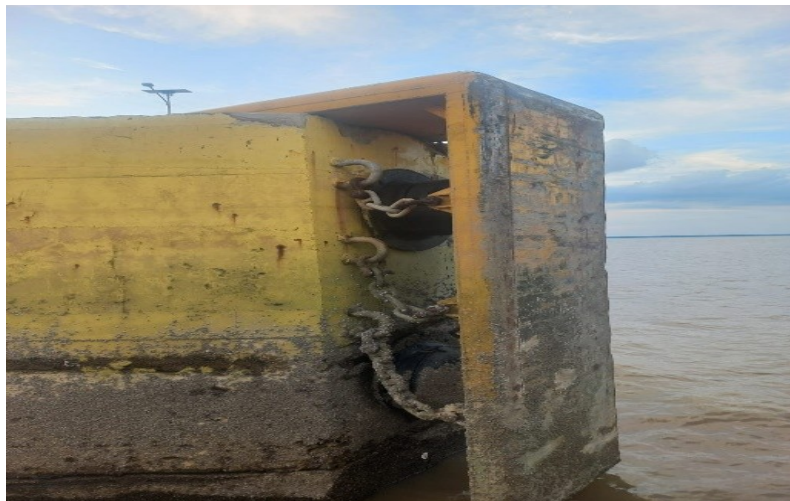
Gambar 4. 14 Fender pelabuhan TAA
