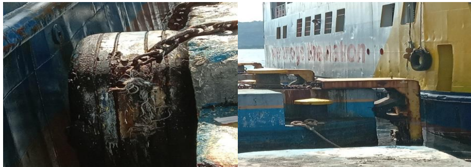
Gambar 4.14 Fender di Pelabuhan ferry ASDP Bitung Sumber : Dokumentasi Peneliti di Bitung (April,2023)
