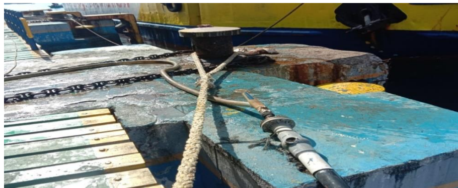
Gambar 4.13 Bolder di Pelabuhan ferry ASDP Bitung
