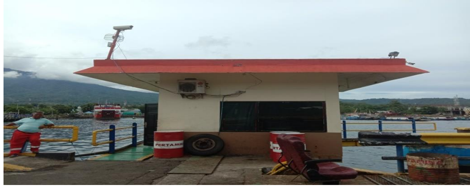
Gambar 4.12 Rumah Moveable Bridge di Pelabuhan ferry ASDP Bitung
