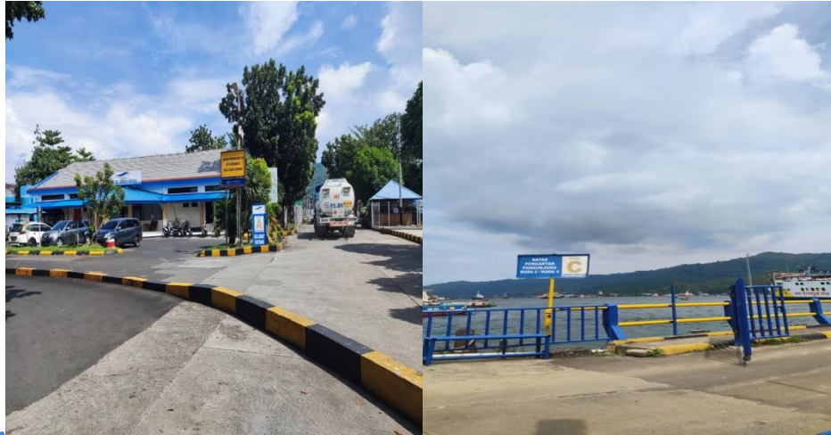
Gambar 4. 55 Peletakan Rambu Zona eksisting
