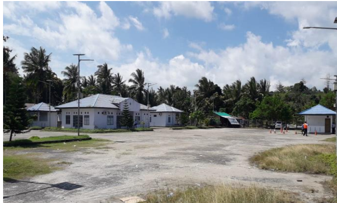
Gambar 4.6 Kondisi Lapangan Parkir 52
