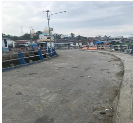
Gambar 4. 7 Trestel/Jembatan Penghubung di Pelabuhan Penyeberangan Tual
