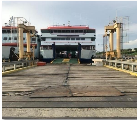
Gambar 4. 6 Dermaga Moveable Bidge Pelabuhan Penyeberangan Tual
