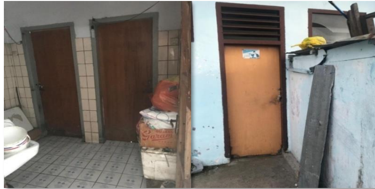
Gambar 4. 12 Toilet di Pelabuhan Penyeberangan Tual
