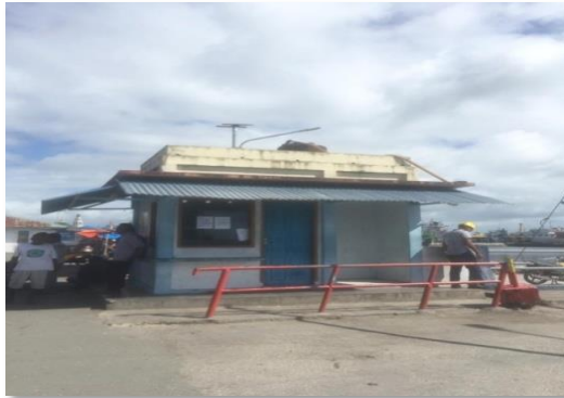
Gambar 4. 10 Loket di Pelabuhan Penyeberangan Tual
