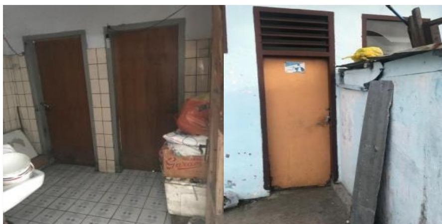
Gambar 5. 6 Kondisi dalam Toilet Pada Pelabuhan Penyeberangan Tual
