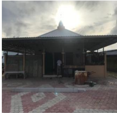
Gambar 5. 7 Kondisi musholla Pada Pelabuhan Penyeberangan Tual
