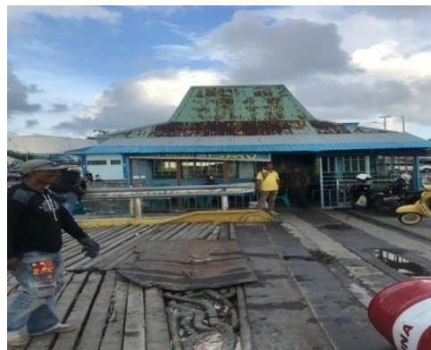
Gambar 4. 11 Rumah Moveable Bridge di Pelabuhan Penyeberangan Tual
