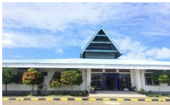
Sumber: Dokumentasi Tim PKL Bajoe, (2020)
