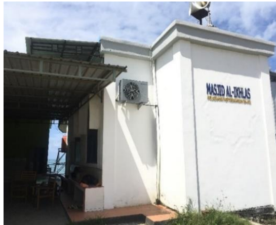
Sumber: Dokumentasi Tim PKL Bajoe, (2020)
