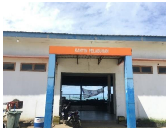
Sumber: Dokumentasi Tim PKL Bajoe, (2020)
