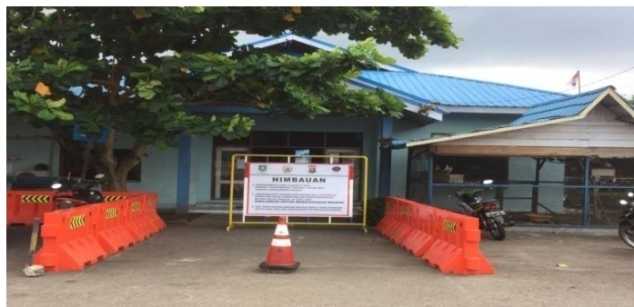
Gambar 4.22 Kantor UPT Pelabuhan Penyeberangan Air Putih
