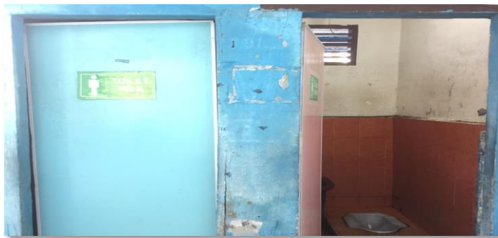
Gambar 4.27 Toilet di Pelabuhan Penyeberangan Air Putih
