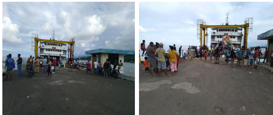
Gambar 4.26. Kondisi Di Trestle
