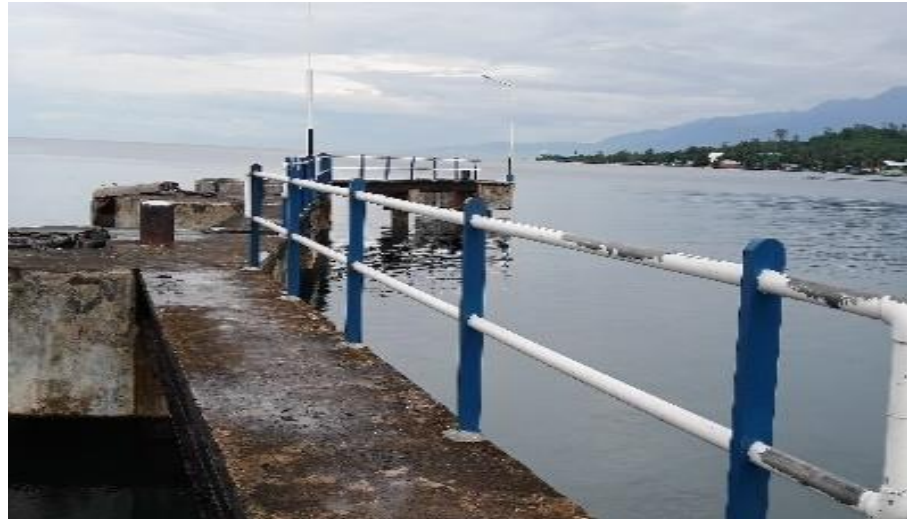
Gambar 4.17. Catwalk Pelabuhan Marampa
