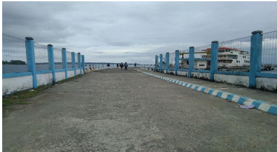
Gambar 4.13. Trestel Pelabuhan Marampa
