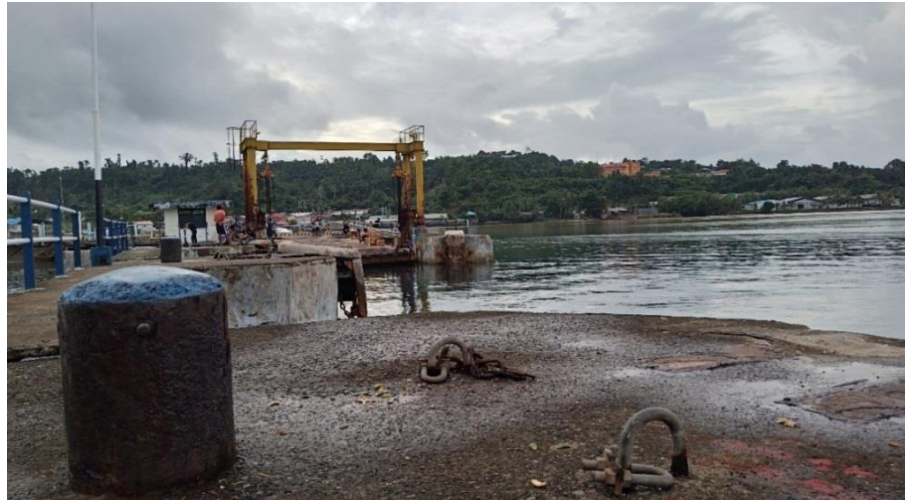
Gambar 4.15. Bolder Pelabuhan Marampa
