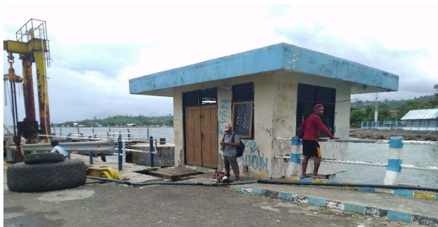
Gambar 4.14. Rumah Movable Bridge Pelabuhan Marampa
