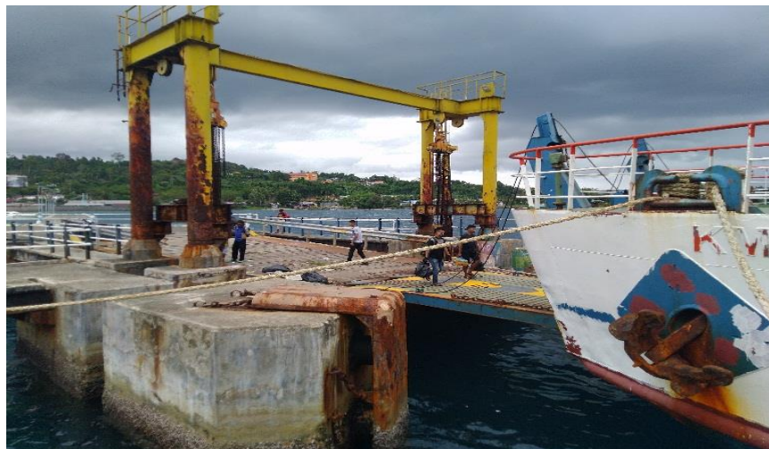
Gambar 4.17 Fender Pelabuhan Marampa
