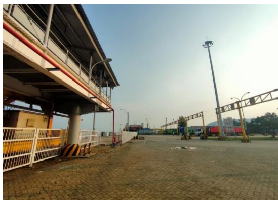
Gambar 5.2 Kondisi Eksisting Gangway
