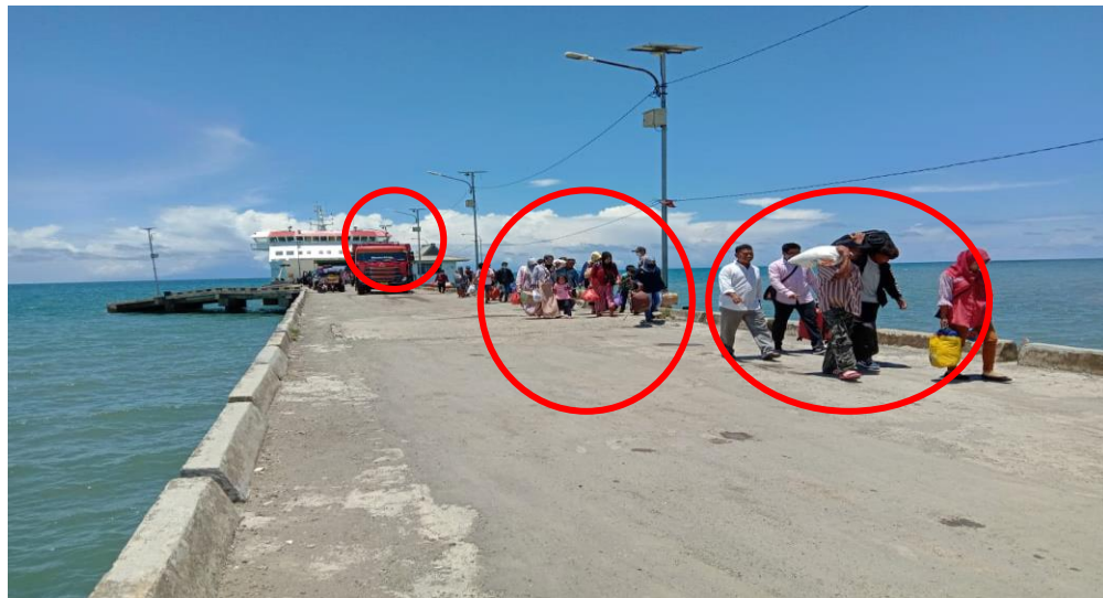
Gambar 1.3. Tidak Adanya Fasilitas Gangway Bagi Penumpang Pejalan Kaki
