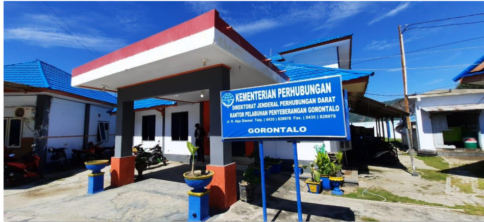
Gambar 4.8. Ruang kantor di Pelabuhan Penyeberangan Gorontalo
