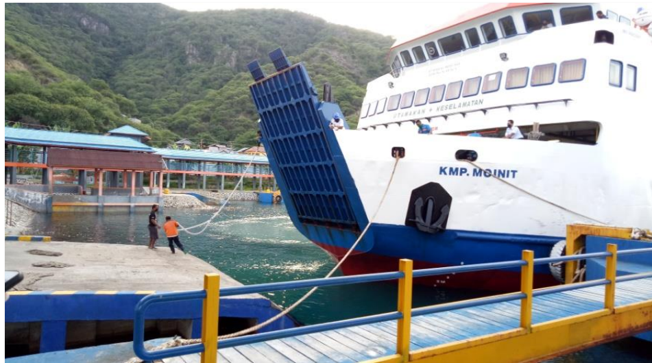
Gambar 4.4. Dermaga plengsengan di Pelabuhan Penyeberangan Gorontalo
