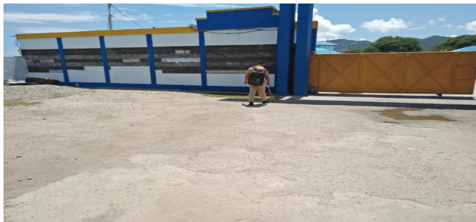
Gambar 4.5. Causeway di Pelabuhan Penyeberangan Gorontalo
