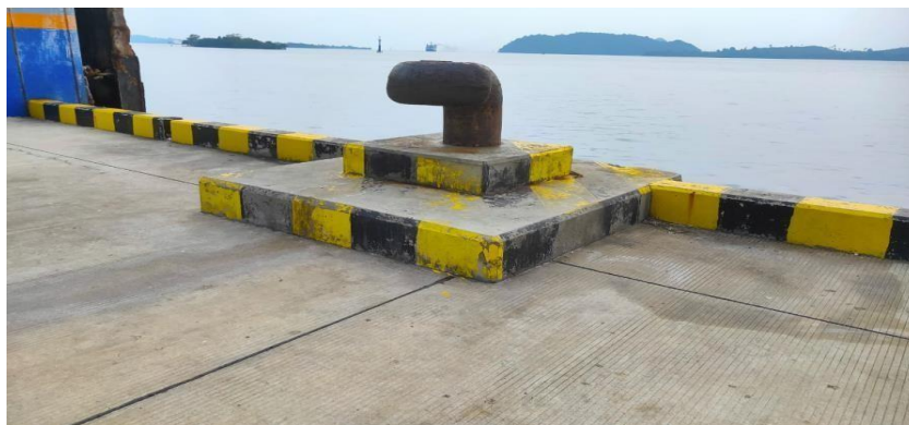
Gambar 4.23 Breasting Dolphin Pelabuhan Penyeberangan Bakauheni.
