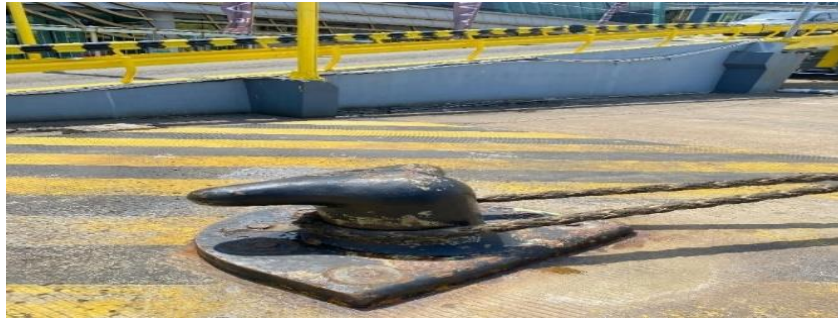
Gambar 4.19 Bolder Pelabuhan Penyeberangan Bakauheni
