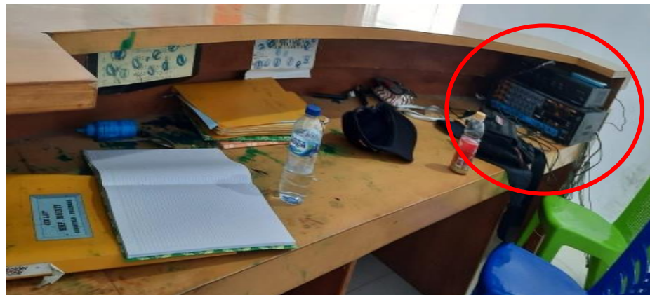
Gambar 5.10. alat pengeras suara di ruang informasi
