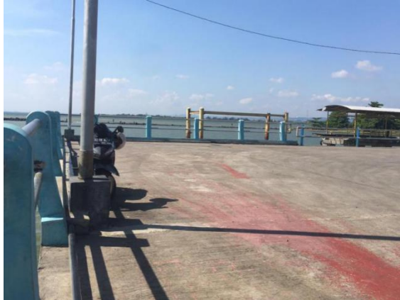
Gambar 4.21 Trestle di Pelabuhan Kendal 39
