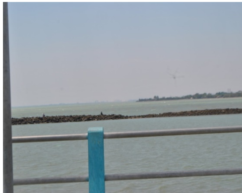
Gambar 4.25 Break Water di Pelabuhan Kendal 43
