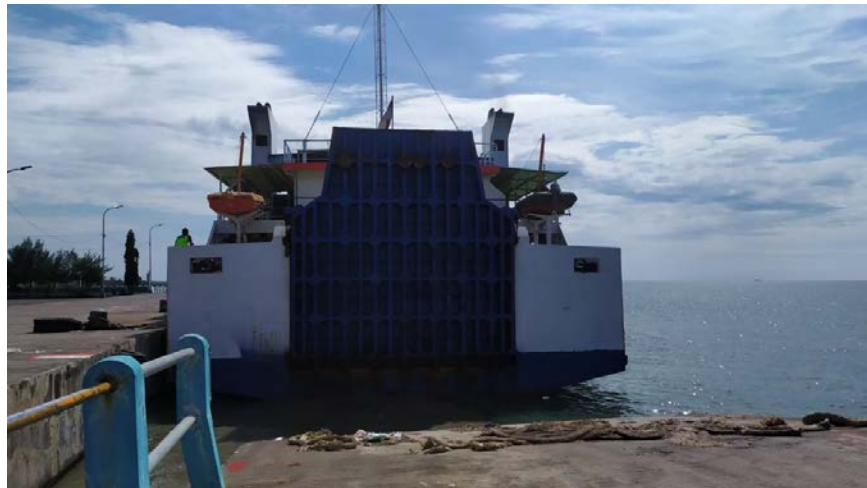
Gambar 5.1 Kondisi Eksisting Dermaga Plengsengan Pelabuhan Penyeberangan Kendal 1
