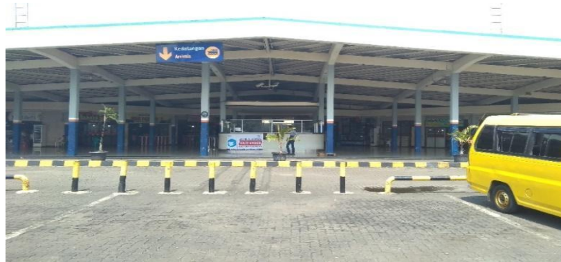
Gambar 4.8 Terminal Kedatangan Bakauheni
