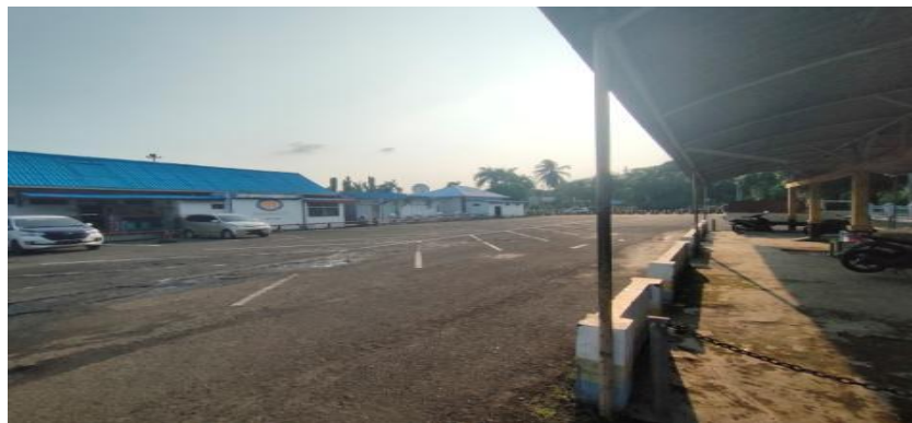
Gambar 4.1 Lapangan Parkir Pelabuhan Bakauheni
