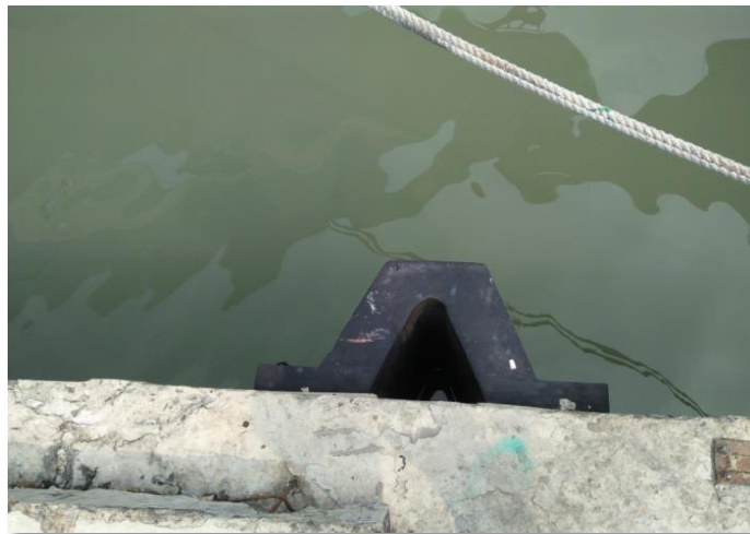
Gambar 4. 17. Fender di Pelabuhan Gresik
