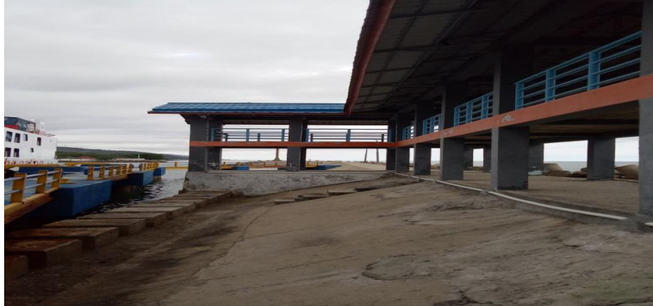
Gambar 4.6. Gangway di Pelabuhan Penyeberangan Gorontalo
