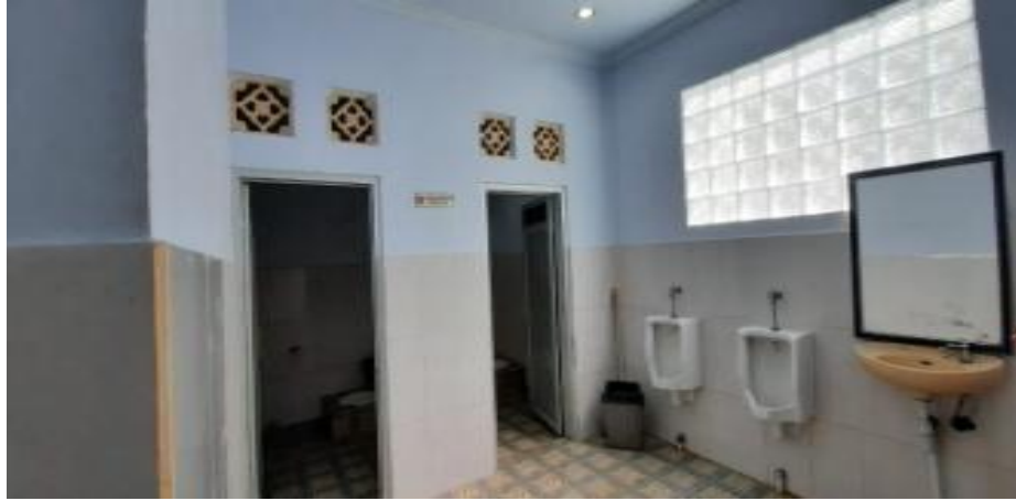
Gambar 4.12. Toilet di Pelabuhan Penyeberangan Gorontalo
