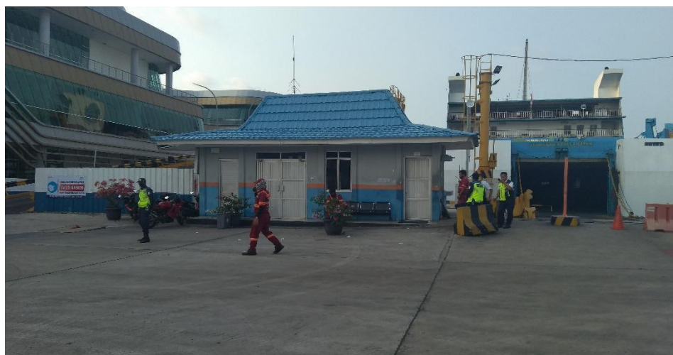
Gambar 5.3 Kondisi Eksisting Zona C Terminal Eksekutif
