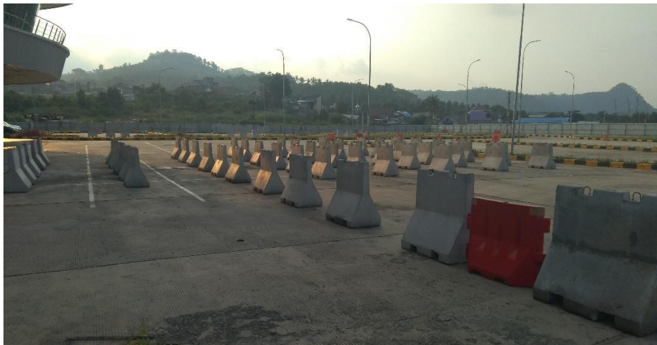
Gambar 5.2 Kondisi Eksisting Lapangan Parkir Antar Jemput
