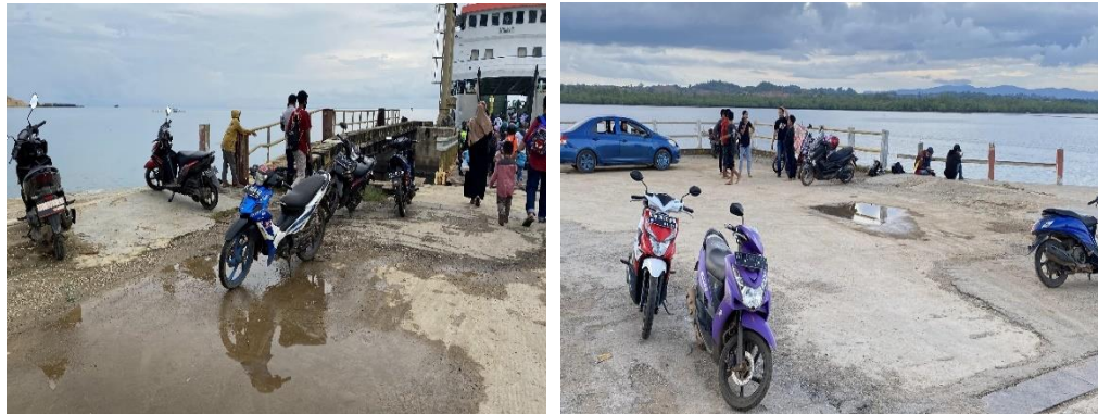
Gambar 4.27 Kondisi di Trestle
