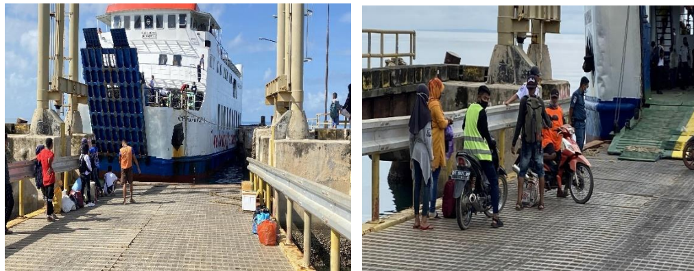
Gambar 4.26 Kondisi di Moveable Bridge
