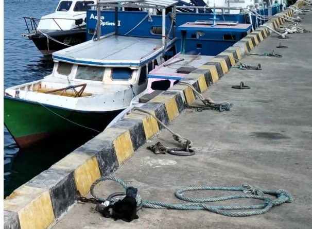
Gambar 4. 14 Bolder di Pelabuhan Penyeberangan Karimunjawa
