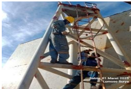
Gambar 4.7. Awak kapal tidak menggunakan safety harness
