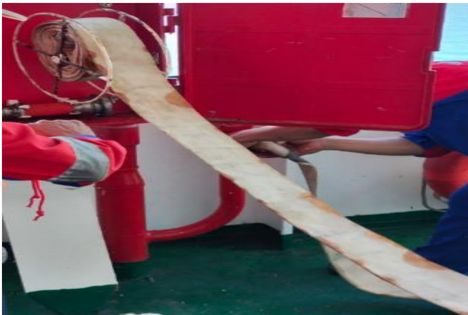
Gambar 4.5 Selang Hydrant karat dan bocor
