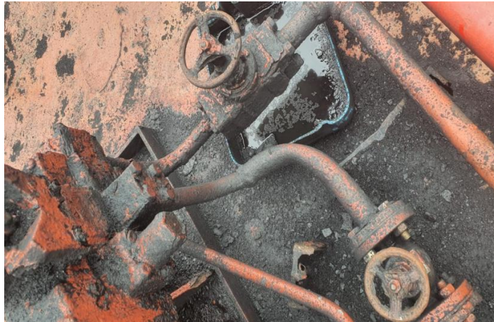
Gambar 4.1. Kebocoran Pipa Hidrolik
