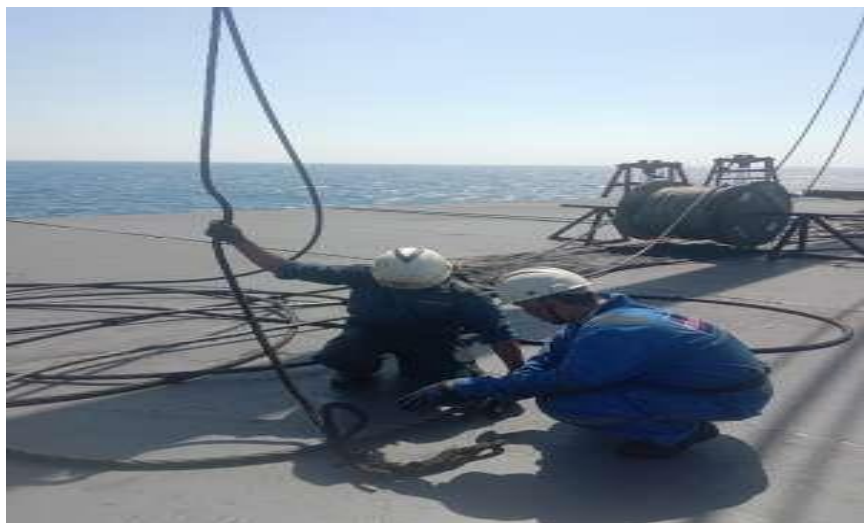
Gambar 4. 11 Penggantian wire crane
