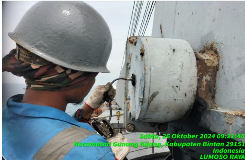
Gambar 4. 9 Pelumasan Jib Crane
