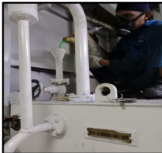
Gambar 4.11 Penambahan cairan chemical pada tanki ekspansi
