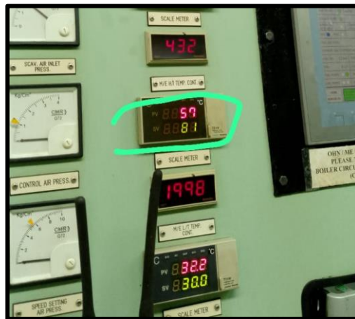
Gambar 4. 3 suhu pada jacket cooling
