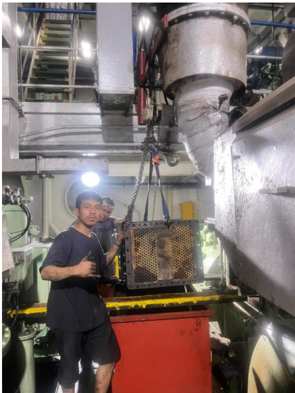
Perendaman pada tube intercooler
