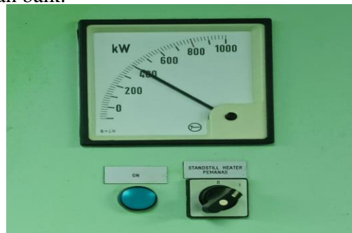
Gambar 4.13 Daya Output Setelah Perawatan
