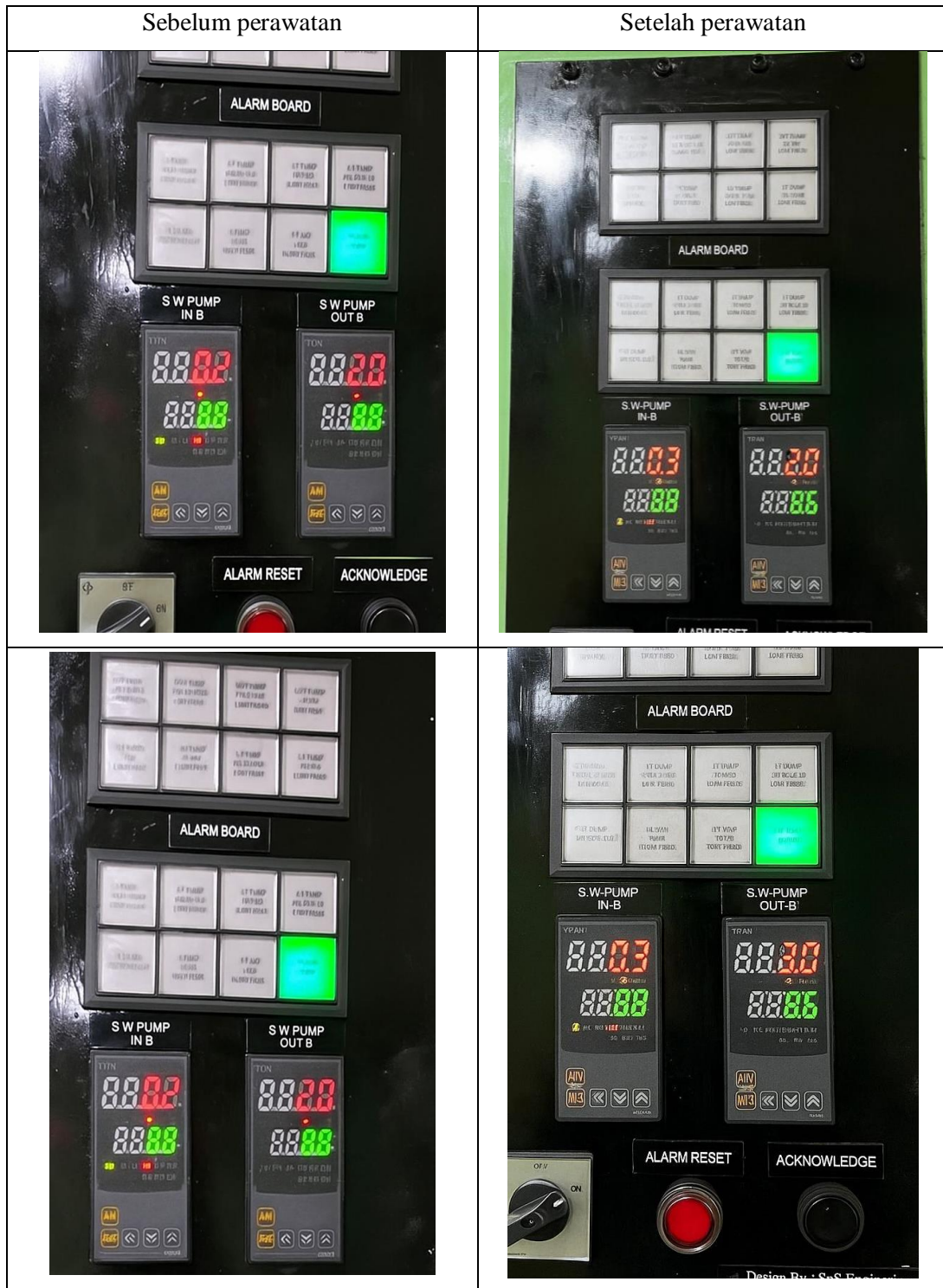
Lampiran 8. 1 Pressure Sea water pump sebelum dan sesudah perawatan
