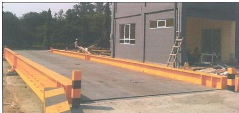
Gambar 2. 10 Jembatan Timbang Permanen Sumber : Peraturan Menteri Perhubungan Nomor 115 Tahun 2016
