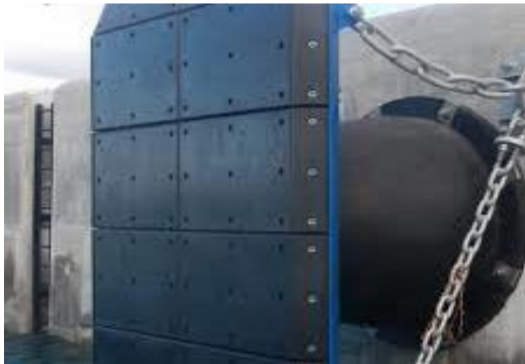
Gambar 2. 10 Fender Tipe Sel
