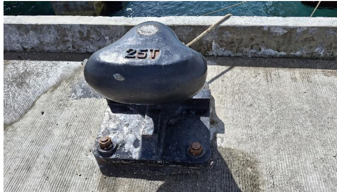
Gambar 4. 16 Bolder Pelabuhan Penyeberangan Kahyapu
