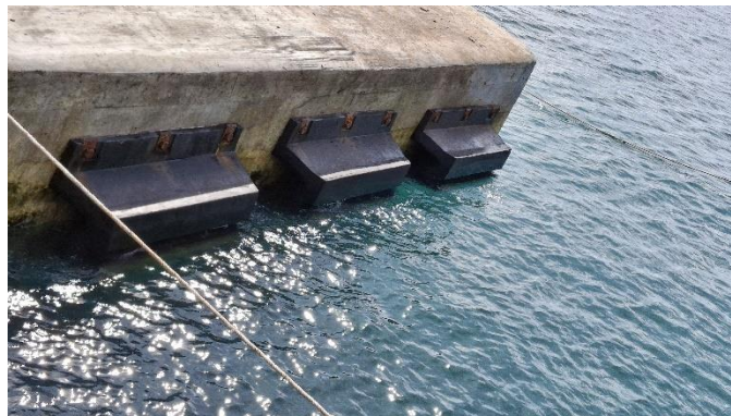
Gambar 4. 17 Fender Pelabuhan Penyeberangan Kahyapu
