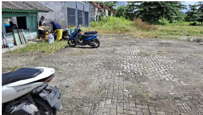
Gambar 4. 24 Kondisi Perkerasan Area Parkir Pengantar dan Penjemput
