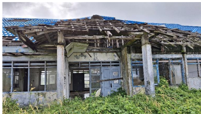
Gambar 4. 28 Kondisi Kerusakan Gedung Terminal
