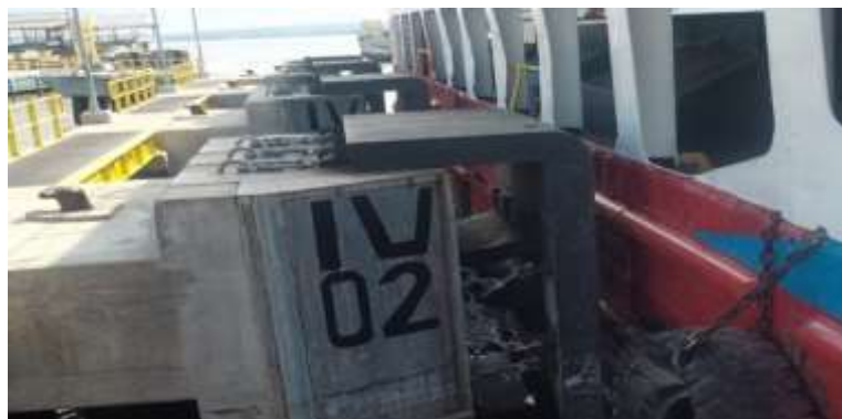
Gambar 4. 18 Fender Pelabuhan Gilimanuk
