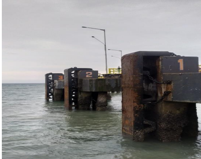
Gambar 4. 32 Fender Pelabuhan Penyeberangan Tanjung Kalian
