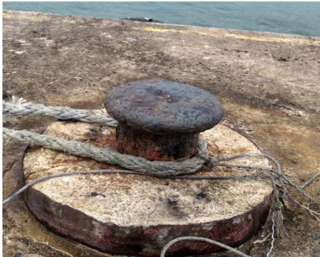
Gambar 4. 31 Bolder Pelabuhan Penyeberangan Tanjung Kalian
